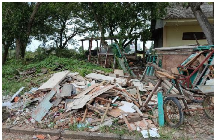
Gambar 3. Limbah Kayu Konstruksi
