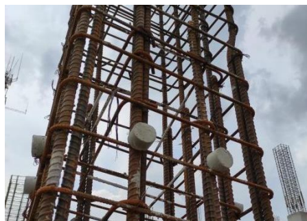
Gambar 4.7. Pemasangan beton decking
