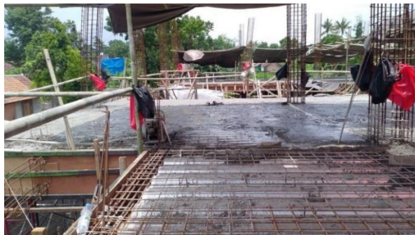
Gambar 4.11. Pemindahan beton ready mix
