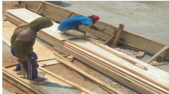
Gambar 4.3. Perakitan Bekisting Kolom
