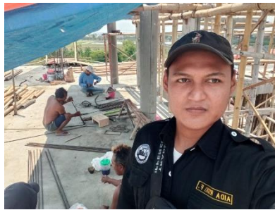
Gambar 4.6. Perakitan tulangan kolom
