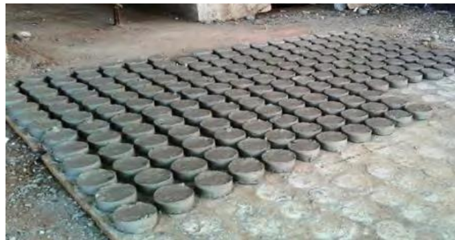
Gambar 4.4. Pembuatan beton decking
