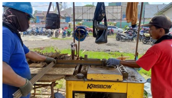
Gambar 4.2. Pembengkokan besi tulangan
