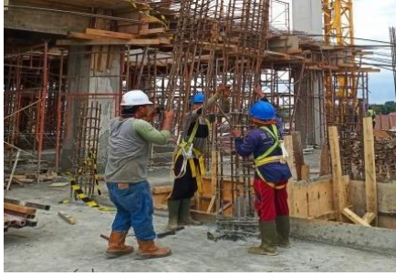
Gambar 4.5. Penyambungan kolom dengan bantuan tower crane
