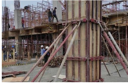
Gambar 4.9. Pemasangan penyangga bekisting
