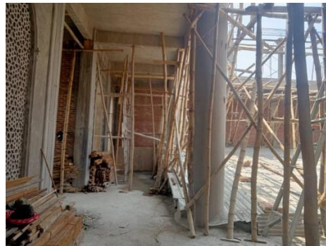
Gambar 4.8. Pemasangan bekisting kolom
