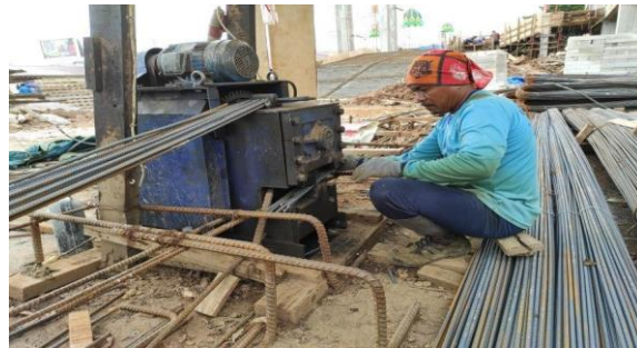
Gambar 4.1. Pemotongan besi tulangan
